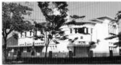
Gedung Kantor Pusat PT Bank NISP
